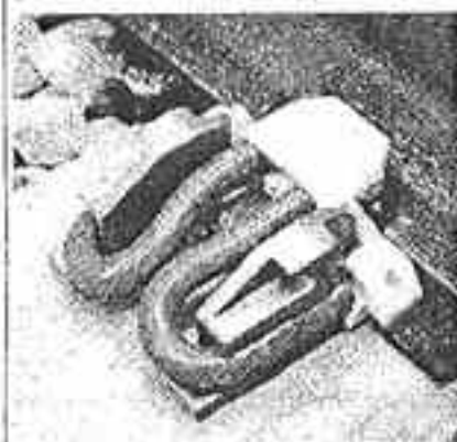
Рис. 14 — Упругое промежуточное бесподкладочное крепление типа Pandrol Fastclip (Англия)
